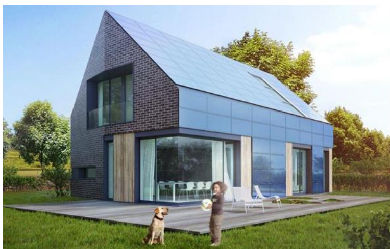
Zdjęcie 3 Fotowoltaika jako fasada budynku jednorodzinnego
